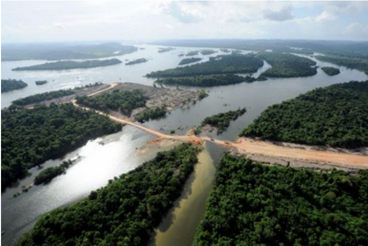
Une vue du site de la construction en mai 2012
