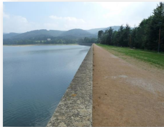
Barrage de Saint Ferréol (France 1672)
